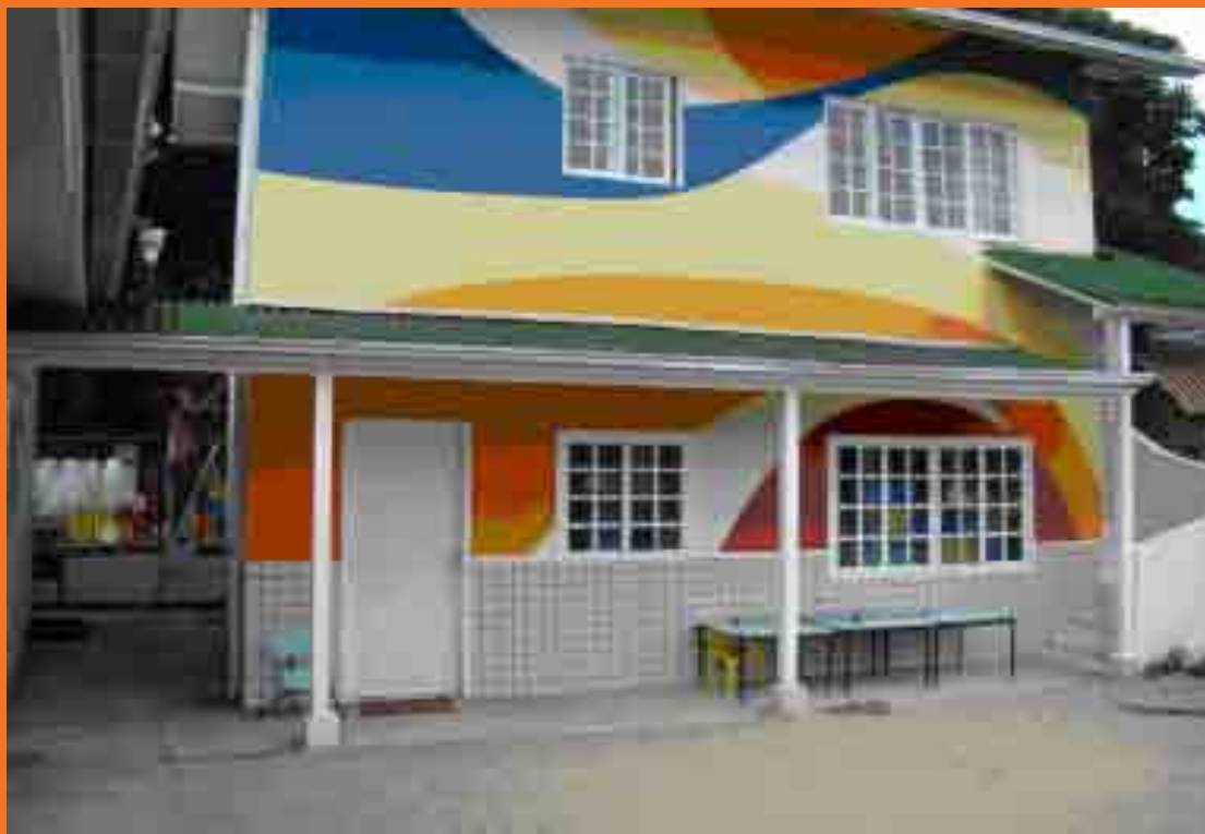
ESCOLA DESDOBRADA E NEI COSTA DA LAGOA
